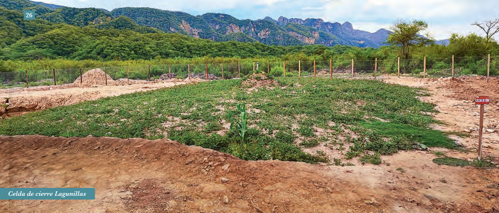
Figura 14. Sistema de cobertura final en la macrocelda de cierre
